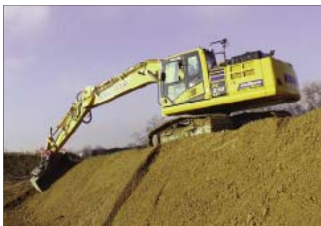
Specjalna łyżka z automatycznym nachyleniem umożliwia pracę koparki w trybie półautomatycznym w dowolnym położeniu maszyny oraz ramienia względem skarpy
